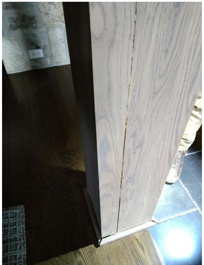
Split edge glued column wrap
